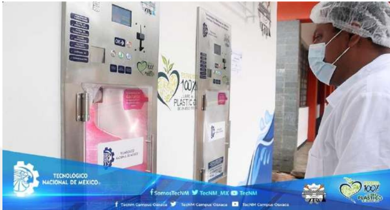
Imagen No. 129 Mantenimiento de la planta purificadora de agua del ITO.
