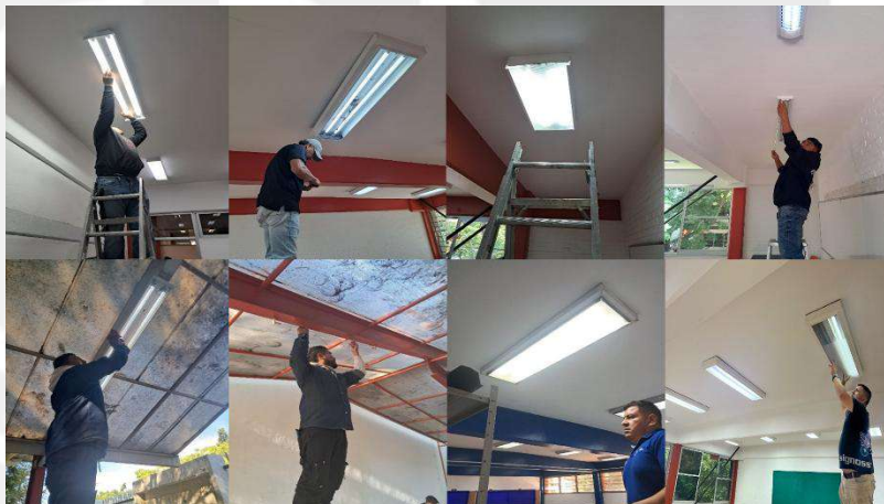
Imagen No. 132 Cambio de lámparas led, contactos y apagadores en aulas y laboratorios.
