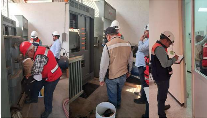
Imagen No. 71 Mantenimiento de la red eléctrica del gimnasio-auditorio.
