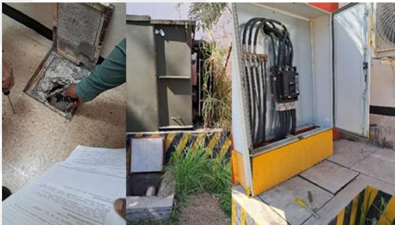
Imagen No. 72 Mantenimiento a las instalaciones eléctricas, levantamiento tapas de los registros y se checo de la subestación del Gimnasio.
