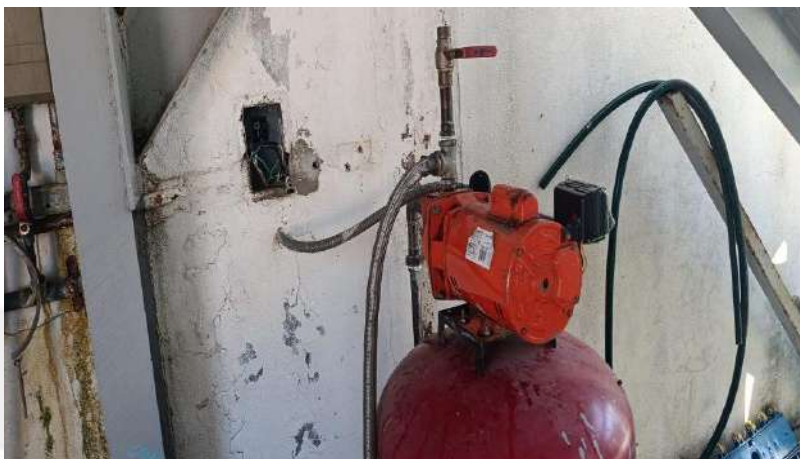
Imagen No. 73 Mantenimiento a la hidroneumatica de la alberca
