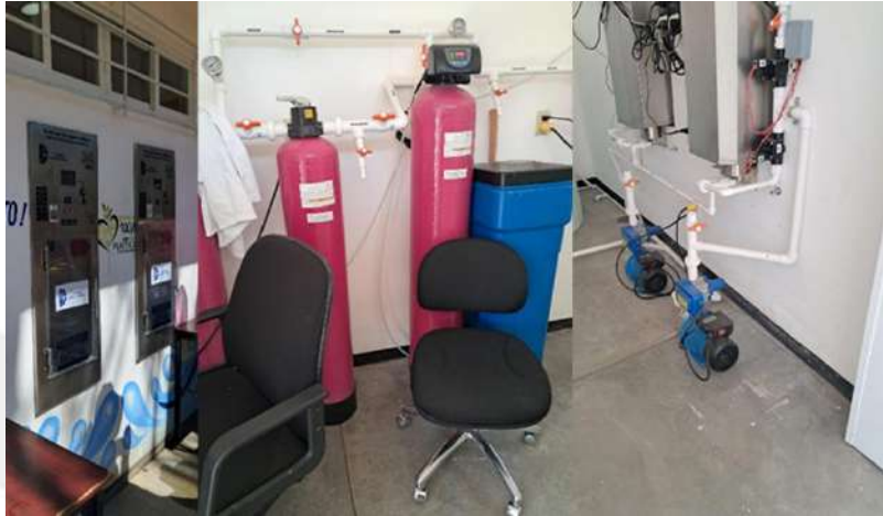
Imagen No. 131 Instalación de nueva bomba en la planta purificadora de agua de la institución.
